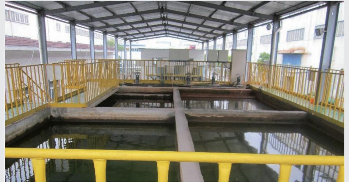
2015年初南通罐箱根据酸洗废水处理过程中产泥量偏多的情况，从酸洗废水的处理工艺入手，优化处理工艺，通过废水处理添加剂配比改良和管路优化等措施，石灰的用量由最高时的每班8袋降低至现在的每班1袋。通过持续的总结、归纳完善，在保证处理效果的同时，实现了污泥减量化，2015年减少污泥167吨，同比降低
